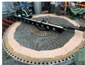
4米法蘭面車削作業
